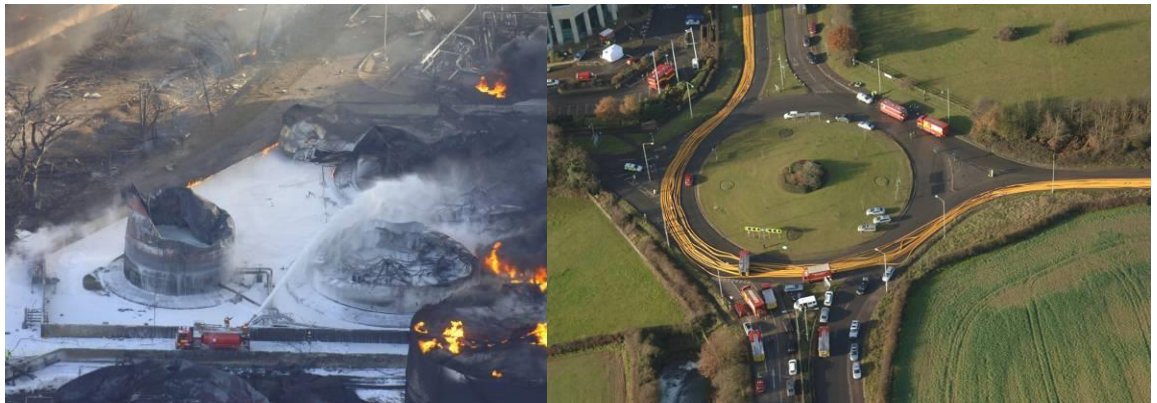
Figur 7: Slukning med skumkanoner og vandforsyning
